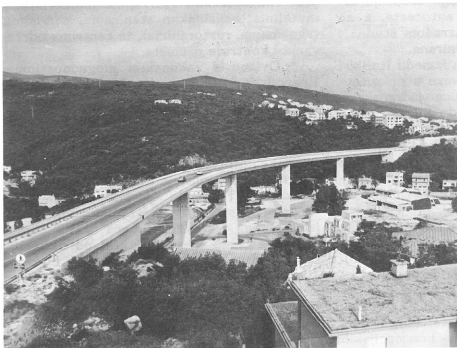
Slika 3 Viadukt Dubračina na obilaznici Crkvenice izgrađen 1980. godine
