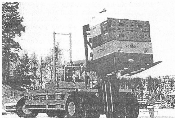
Slika 7. Probno ispitivanje viljuškara nosivosti 80 tona
